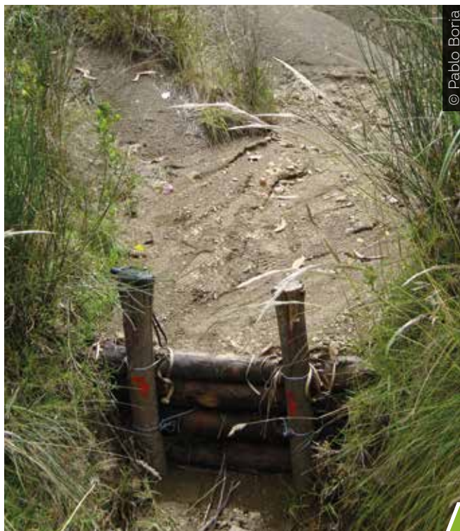
/ BARRAGE EXPÉRIMENTAL AU NIVEAU D'UN BASSIN VERSANT DÉGRADÉ
